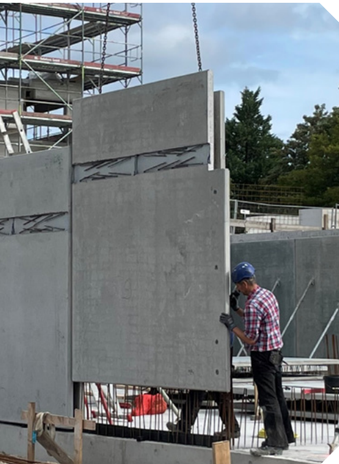
Einsatz eines Betonfertigteils aus Geopolymerbeton
