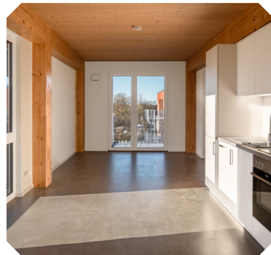
Der Holzhybridbau sichtbar im Küchen- und Wohnbereich
