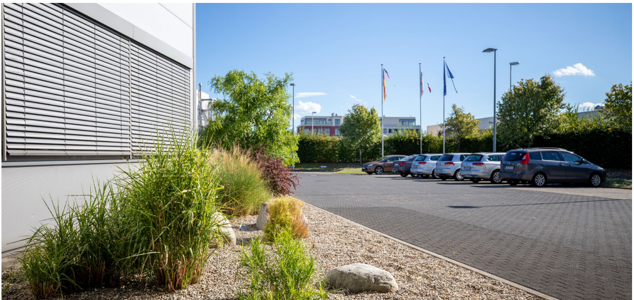
VITLAB GmbH at the Großostheim site
