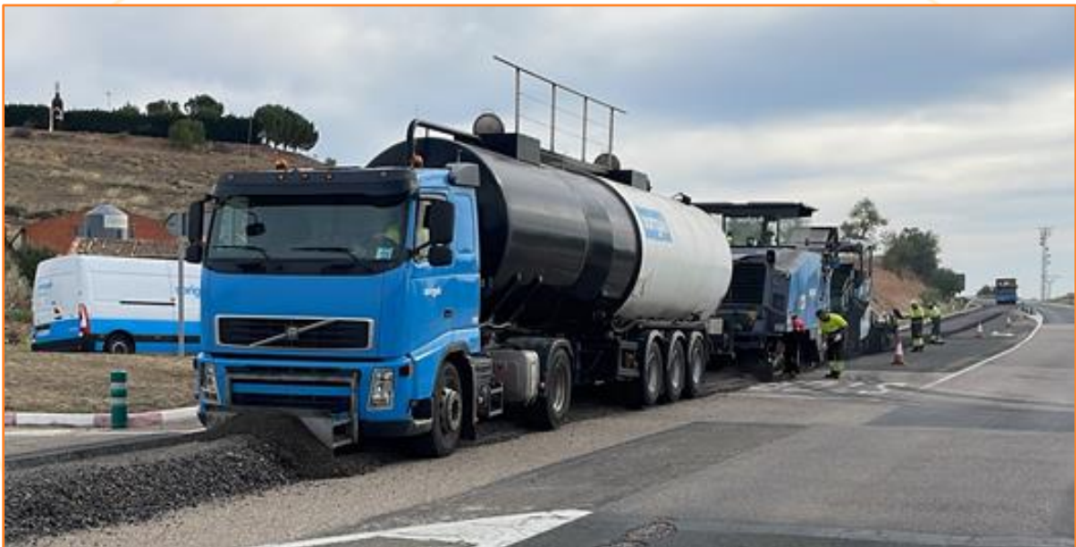
Detalle de la estabilización de firme existente mediante emulsión
