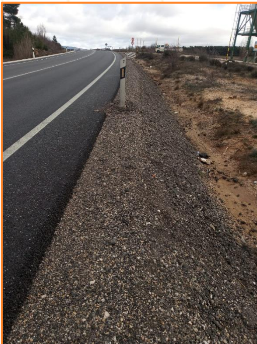
Detalle utilización de Fresado en Berma N-122
