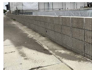
【水害対策】 水路境界の嵩上げ
