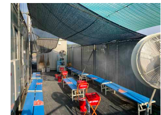
遮光ネットを用いた休憩スペース
