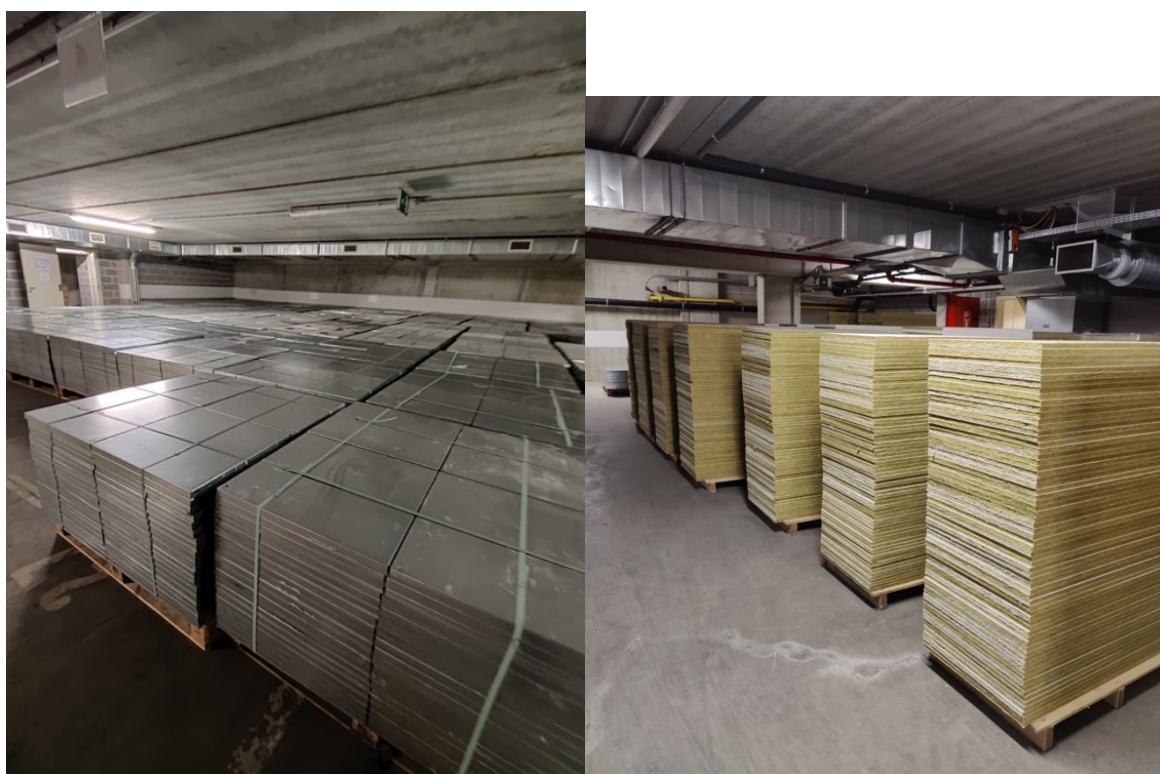
Boven: ontmanteling van het vroegere gebouw en klaarmaken voor hergebruik op een andere toepassing.
