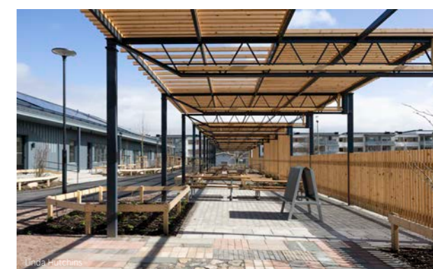
Den ståtliga pergolan som är tillverkad av förskolans tidigare stålstomme har placerats på gården för att erbjuda skugga och skydd under varma dagar.
