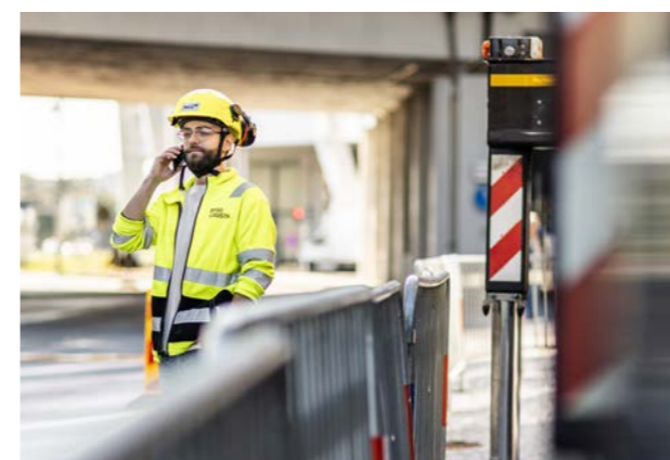
Grand Central - Göteborgs nya stationshus byggs av Peab på uppdrag av Jernhusen.
