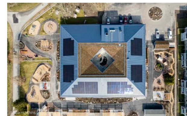
Flygbild över förskolan. Här syns atriumgården, sedumtaket och det plåttak som är lackerat och återbrukat till detta projekt.
