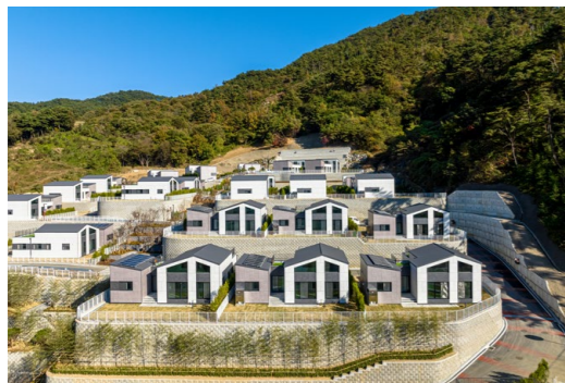
모듈러 주택 시공 사례
