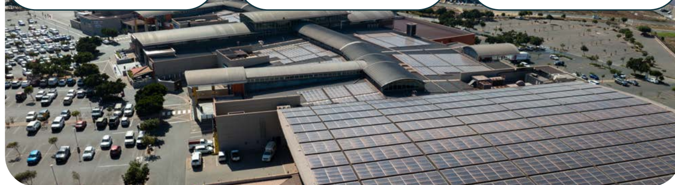
Solar panels at Weskus Mall
