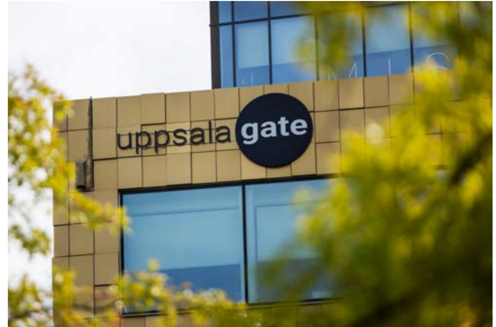
Uppsala Gate, the Kungsängen 10:1 and 10:2 properties, certified according to Miljöbyggnad Silver and Miljöbyggnad Gold.
