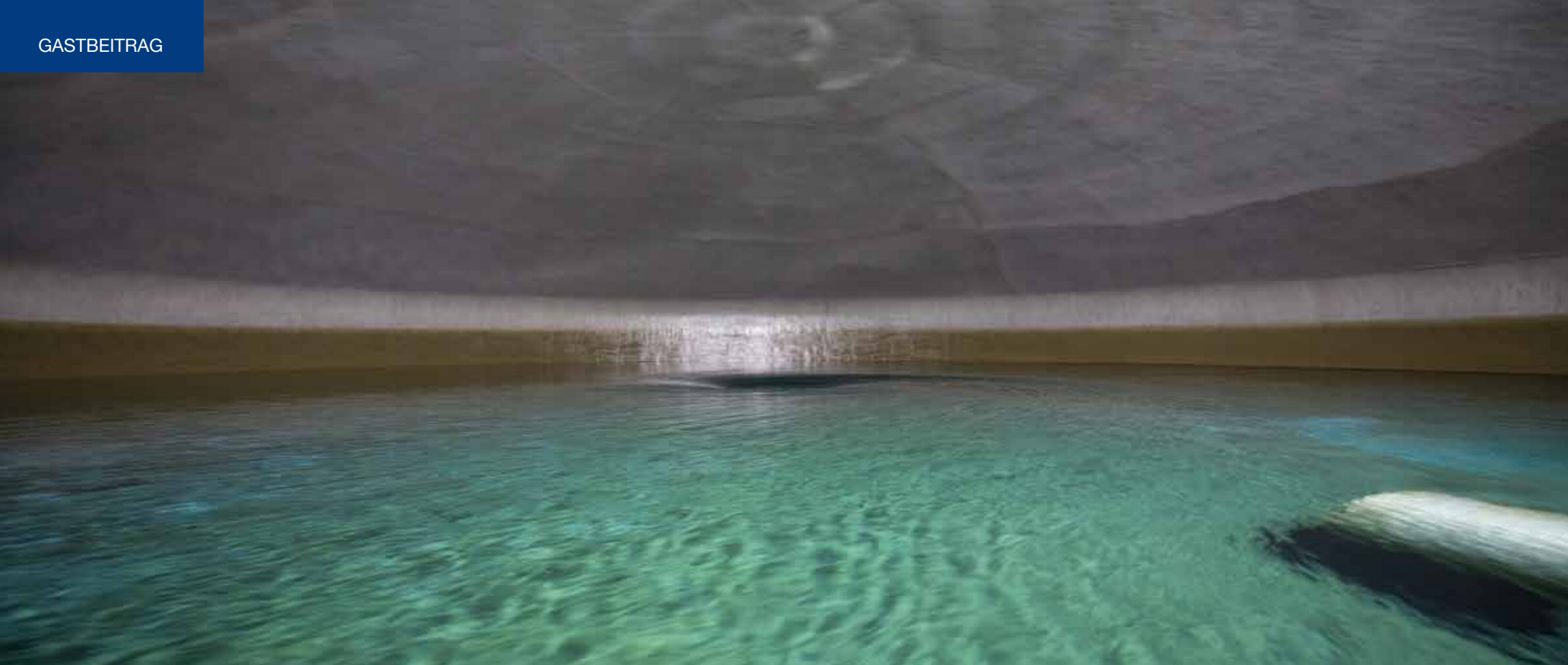
Blick in einen frisch sanierten Wasserbehälter.
