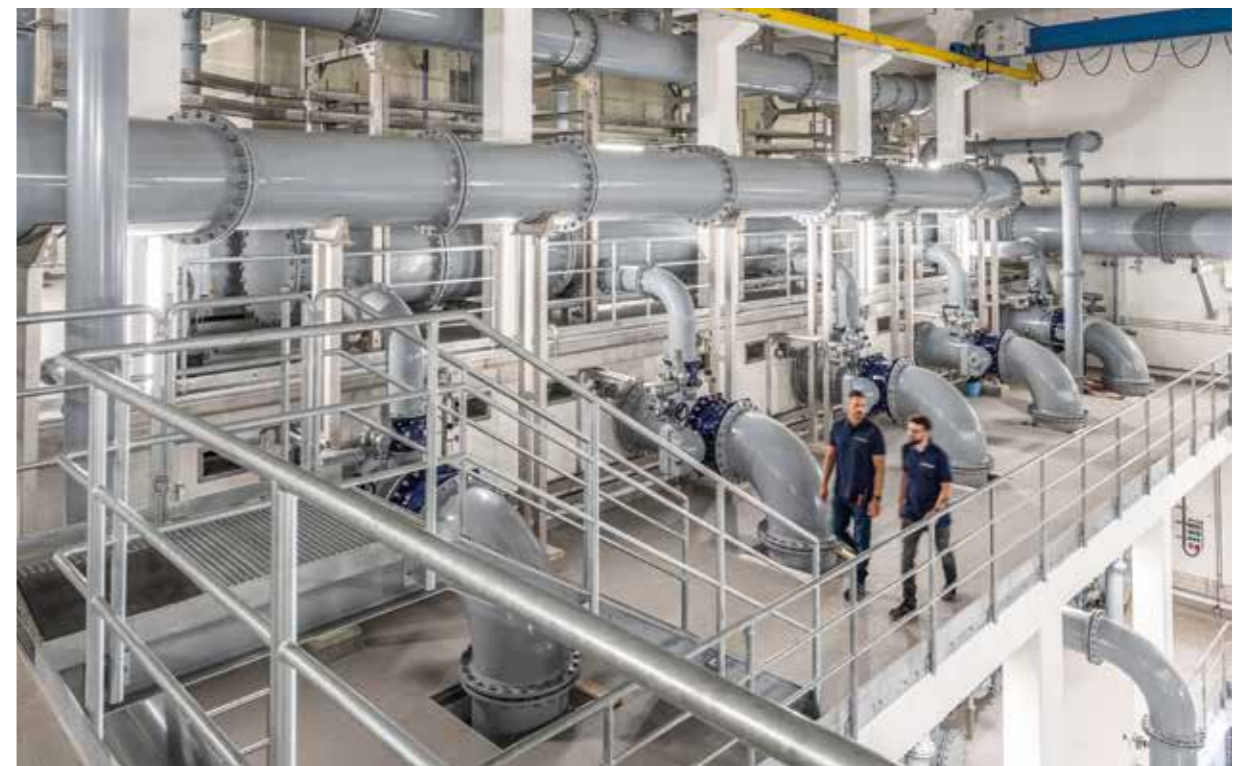
Blick ins Wasserwerk.
