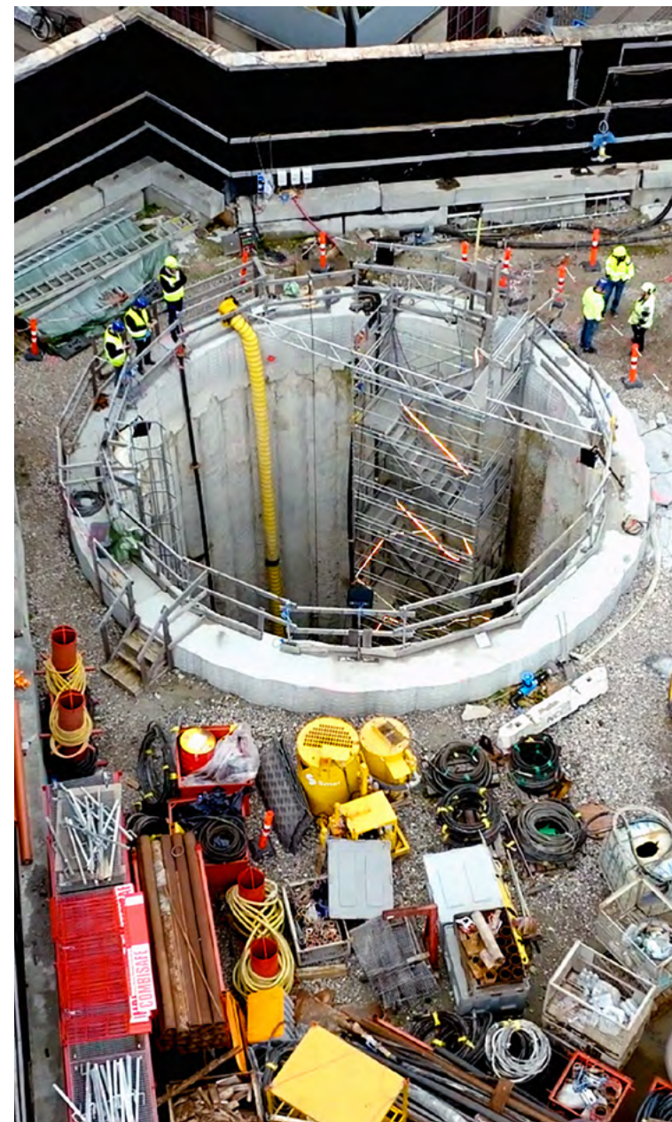
Skabt ned til Kalvebod Brygge Skybrudstunnel
