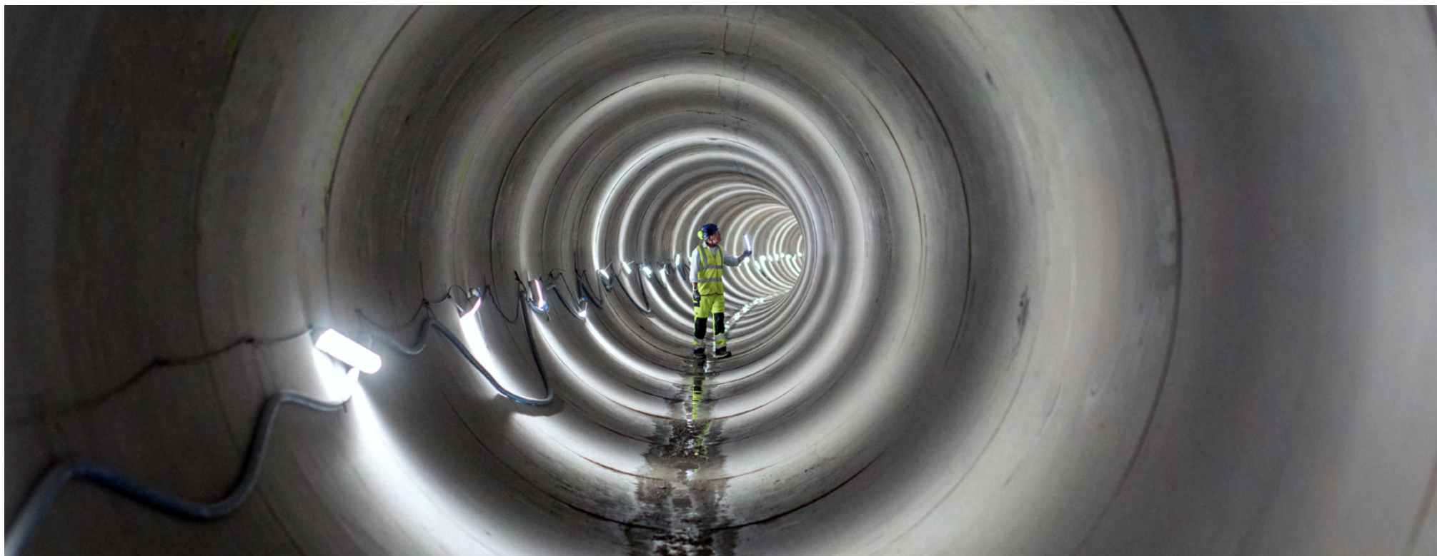
Kalvebod Brygge Skybrudstunnel
