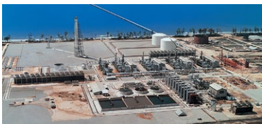
Brunei LNG plant
