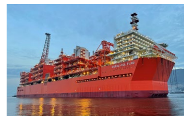
Offshore LNG facility (Mozambique)
