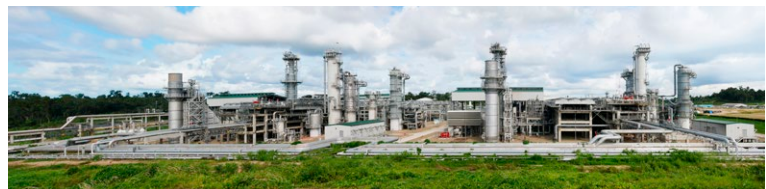
LNG plant (Indonesia)
