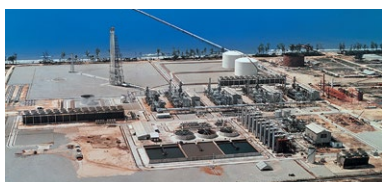
Brunei LNG plant
