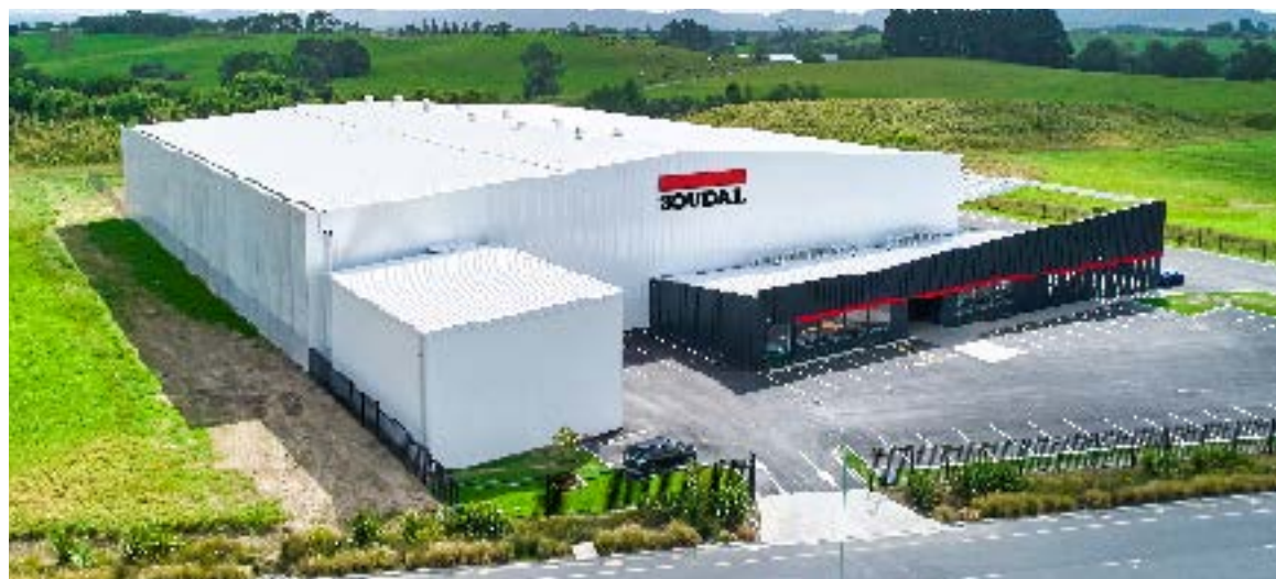
Nieuw distributiecentrum met kantoorgebouw • Nieuw-Zeeland
