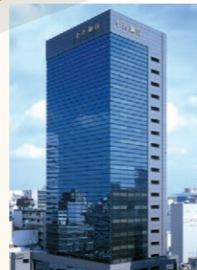
名古屋ビル(名古屋市)
