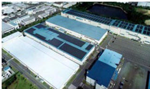
西神工場 728kW発電設備
