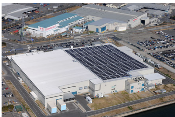
名古屋第一工場 750kW発電設備
