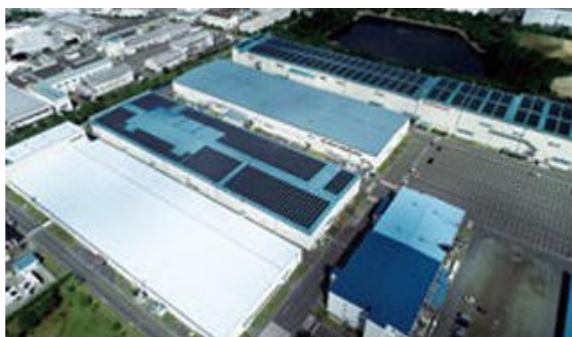
西神工場 1,444kW発電設備
