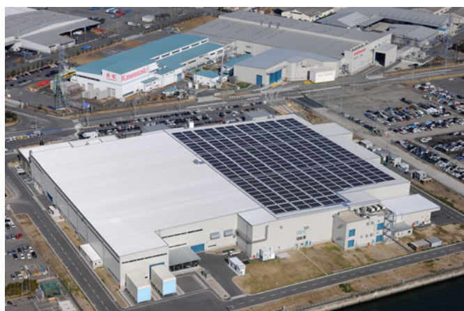
名古屋第一工場 750kW発電設備
