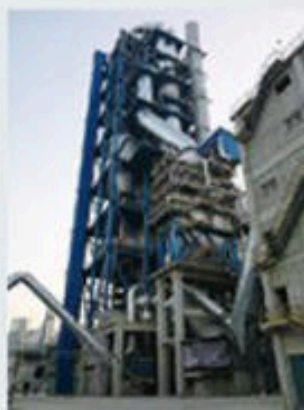
セメントプラント 排熱発電設備
