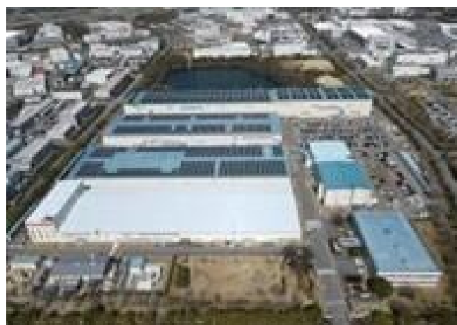
西神工場 1,444kW発電設備
