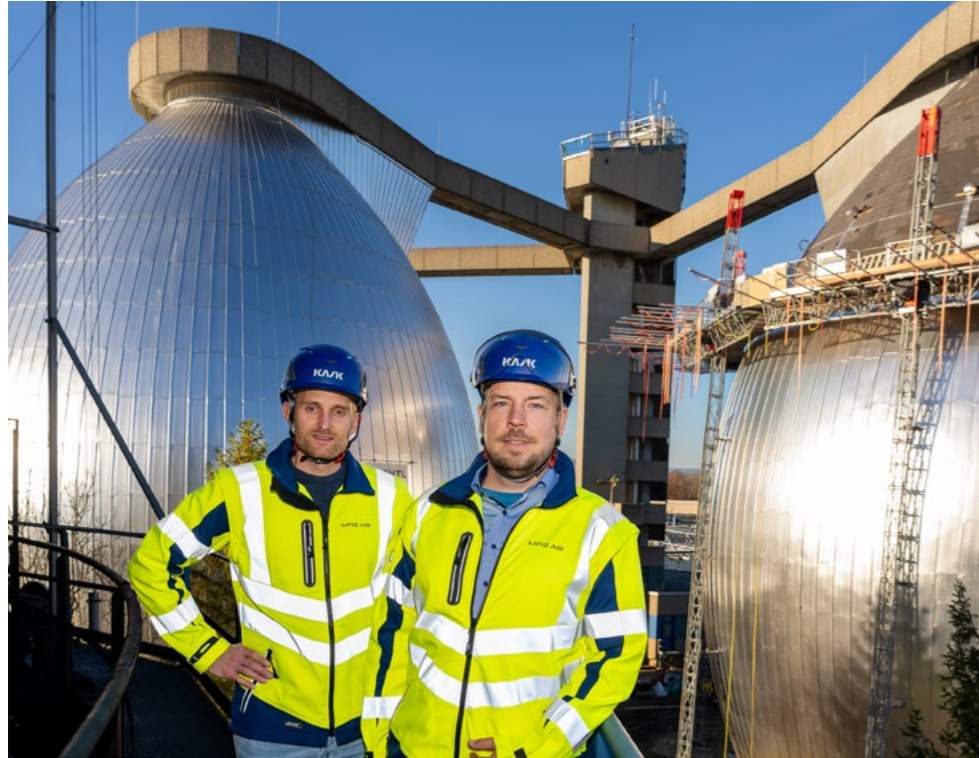
Ing. Alexander Peter Aigner (l.) und Martin Wörister, M.Sc., sind maßgeblich an der Erneuerung der Gasanlagen der Regionalkläranlage Asten beteiligt.
