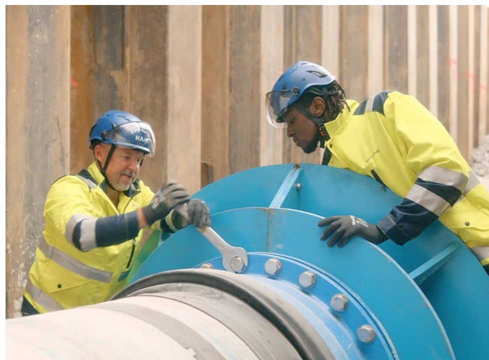
Christian Bräuer und Shandrac Mulumba Cambeia (beide LINZ AG WASSER) arbeiten an der Umliegung einer großen Transportwasserleitung für Linz.
