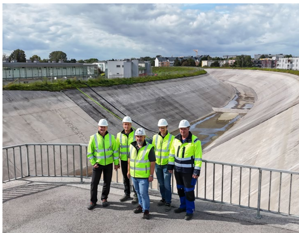
Zusammenarbeit wird bei der Sanierung des Oberwasserkanals großgeschrieben. Im Bild v.l.: Manfred Hanser, Energieerzeugung, Hans-Peter Rodleitner, Baumanagement, Johann Petermüller, Energieerzeugung, Andreas Blaha, Energieerzeugung, Jürgen Pichler, Baumanagement
