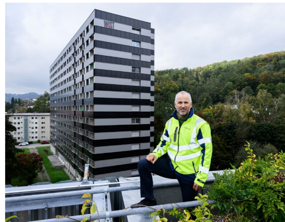
Mit dem Projekt WIST-Heim in Linz realisierte die LES die größte Photovoltaik-Fassade Österreichs mit integrierter Speichertechnik. Im Bildvordergrund: Projektleiter Joachim Moritz, D-Wirt.I. (BA).
