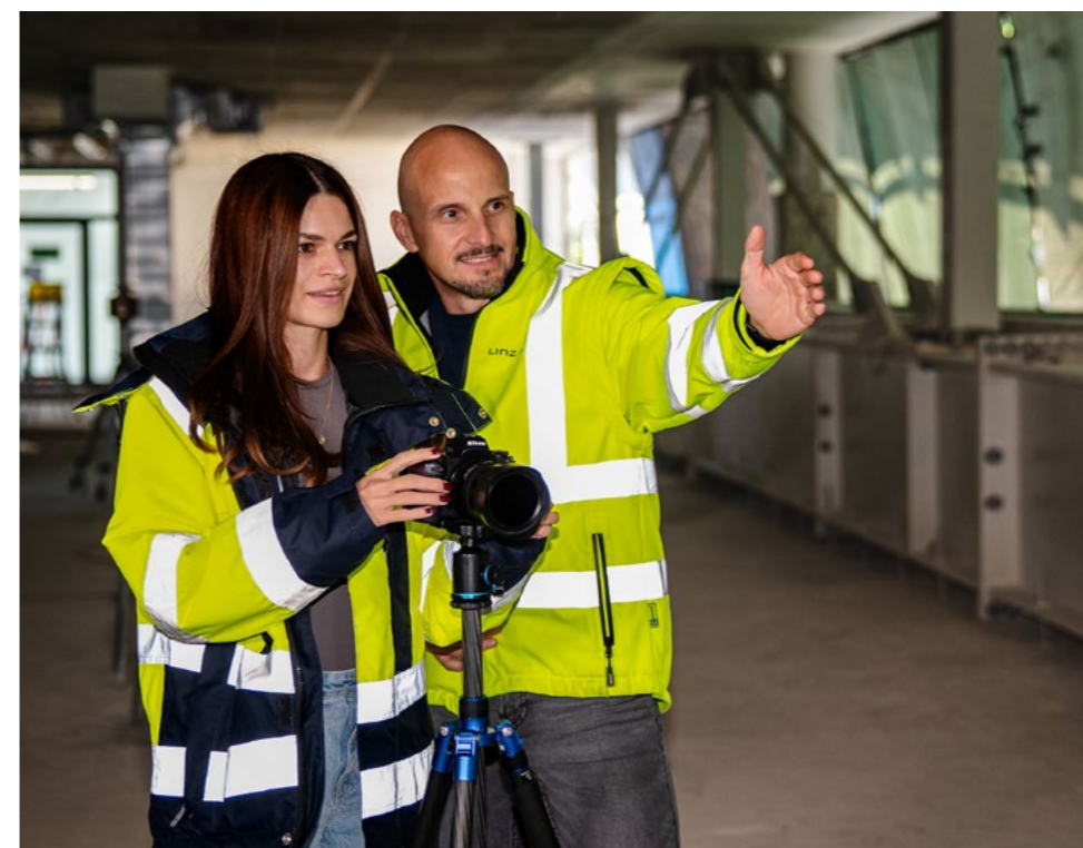
Laura Elena Renz und Stephan Strassern, beide Gebäudemanagement, dokumentieren den Baufortschritt beim „Umbau Bauteil B“ fürs telefonische Kundenservice.
