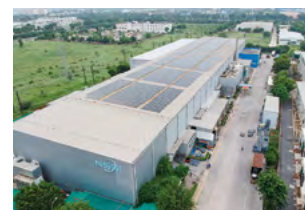
Neembrana Steel Service Center India Pvt. Ltd. (Neembrana Plant)
