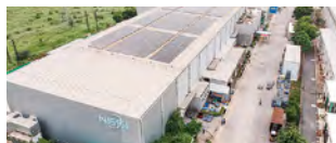
Neemrana Steel Service Center India Pvt. Ltd.【ニムラナ工場】
