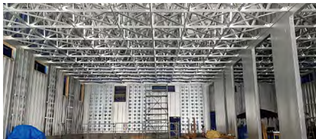
NSスーパーフレーム工法®(施工時)
