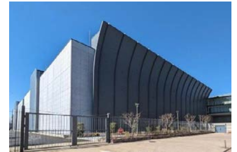
三鷹データセンター EAST
