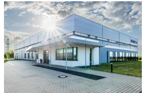
Bautzen Data Center 4 Bautzen, Germany
