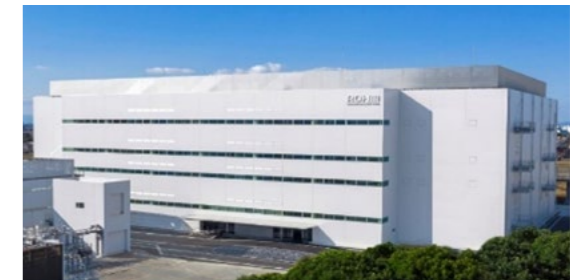
ROHM Apollo Co., Ltd.(Chikugo Plant)
