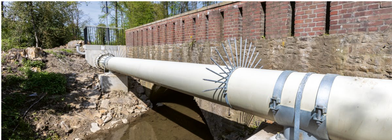
Der Anschluss der Kläranlage Abtsküche in Heiligenhaus an die Kläranlage Essen-Kettwig ist ökonomisch und ökologisch sinnvoll. Zuvor muss ein rund fünf Kilometer langer Anschlusskanal gebaut werden.
