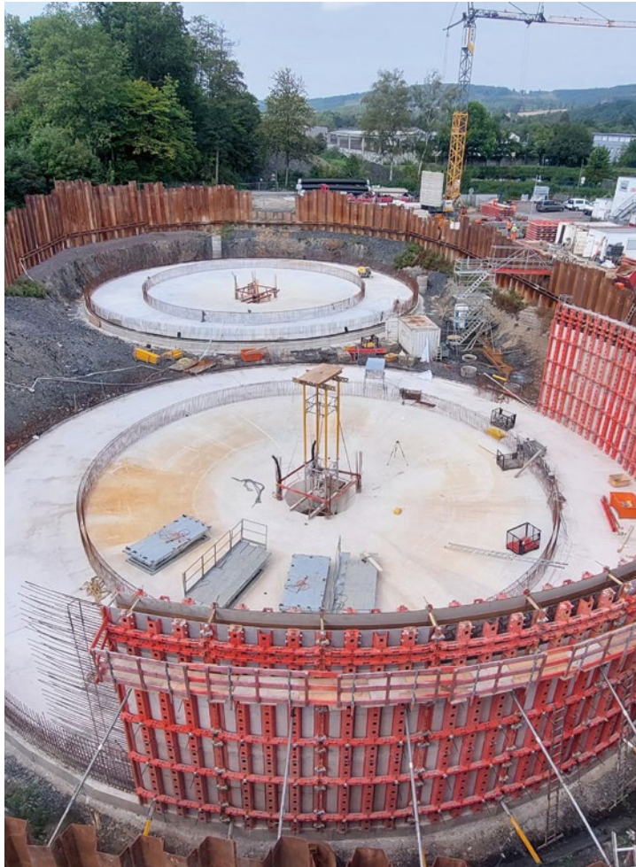
Die beiden neuen Kombibecken sind Teil der umfassenden Erneuerungsarbeiten auf der Kläranlage Arnberg. 2026 soll alles fertig sein.
