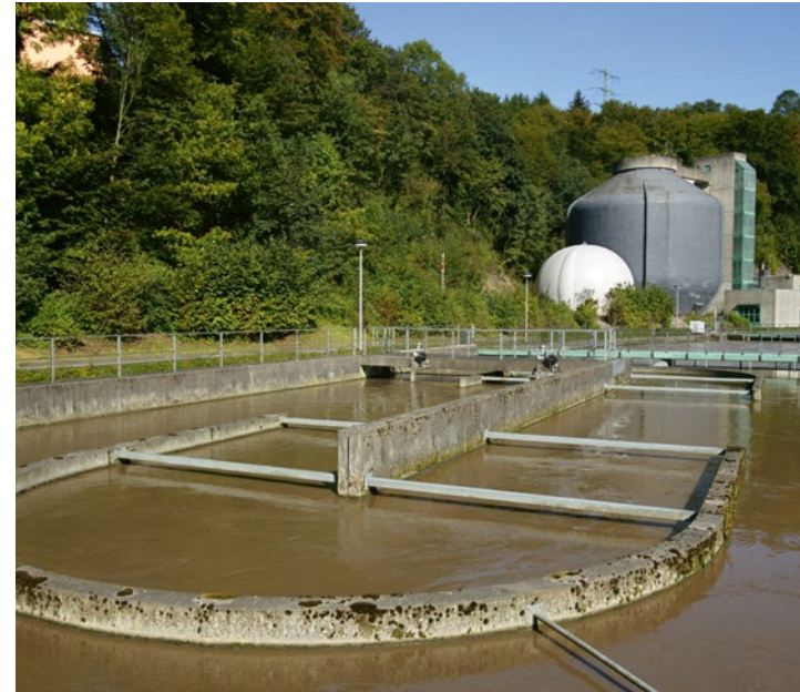
Die Kläranlage Rahmedetal wird für mehr als 23 Millionen Euro ertüchtigt. Das wirkt sich unter anderem positiv auf die Reinigungsleistung aus.
