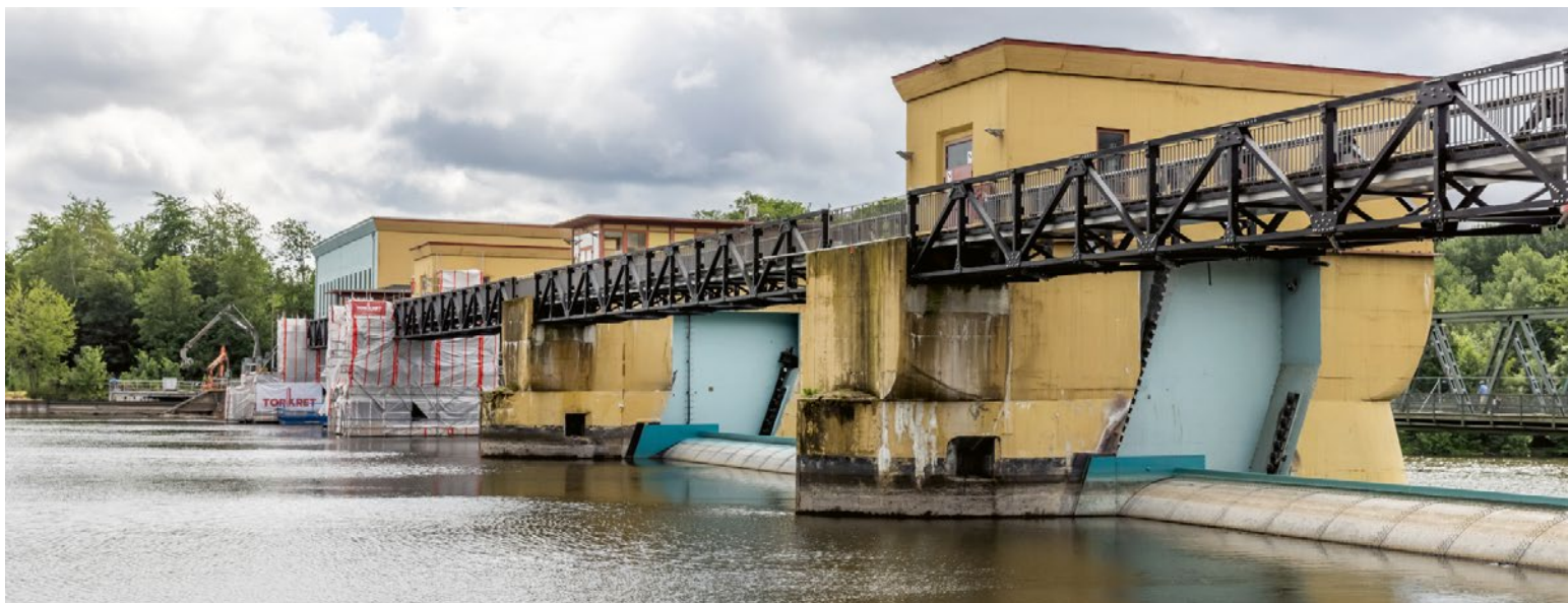
Die mehr als 90 Jahre alte Wehranlage am Hengsteysee wird in mehreren Bauabschnitten umfassend saniert und technisch erneuert.
