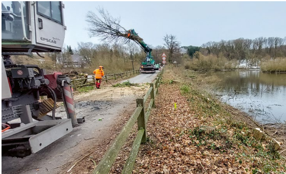
Fotos oben: Die Rampenzufahrt zur Wameler Brücke an der Möhnetalsperre wurde erneuert und tiefergelegt. Dies verbessert im Hochwasserfall den Schutz für AnliegerInnen.
