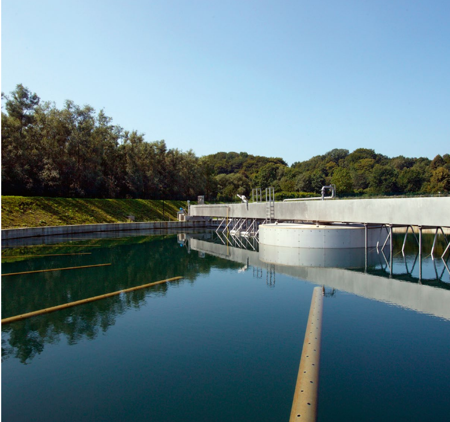
Eine effiziente Abwasserentsorgung und -reinigung (im Bild: Kläranlage Essen-Süd) überall auf der Welt zu erreichen, ist eines der Nachhaltigkeitsziele der Vereinten Nationen.
