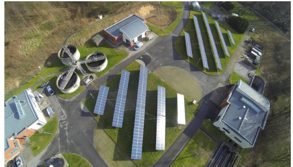
Wie hier auf der Kläranlage Essen-Kettwig wird auf mehreren Betriebsanlagen des Ruhrverbands Strom aus erneuerbaren Quellen erzeugt.
