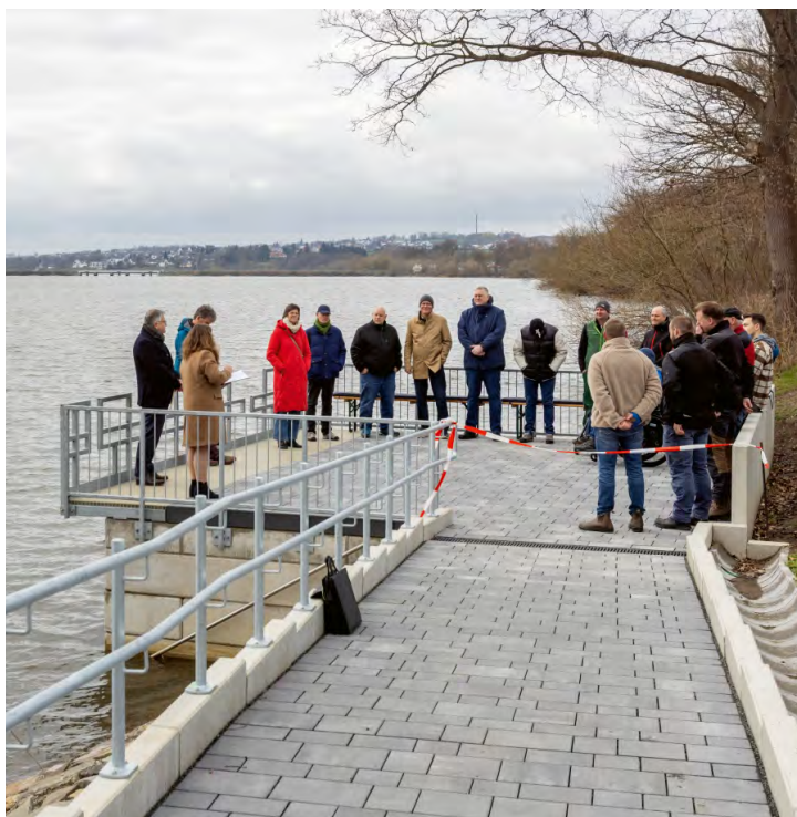
Der barrierefreie Angelplatz am Wameler Vorbecken der Möhnetalsperre wurde im Frühjahr 2025 eröffnet. Er bietet Platz für bis zu vier Rollstühle.
