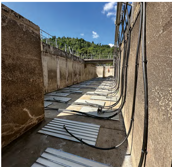
Belebungsbecken 1 der Kläranlage Plettenberg kurz vor der Inbetriebnahme. Die Erstellung des Beckenausschnitts im laufenden Betrieb war besonders anspruchsvoll.
