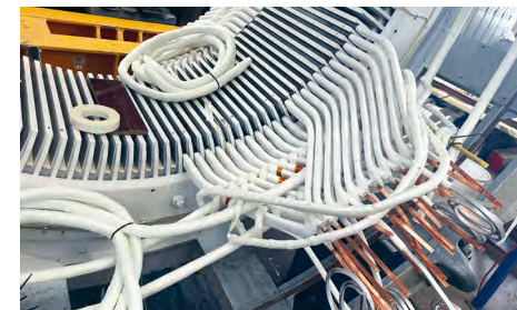
Derr Generator im Kraftwerk an der Listertalsperre musste nach fast 60 Betriebsjahren neu gewickelt werden. Oben im Bild der demontierte Stator, unten die ersten neuen Spulen.
