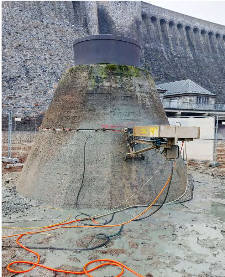
Bei entleertem Ausgleichweiher gut erkennbar war die Kegeldüse von Grundablass III, die noch aus den 1950er Jahren stammte und mittels Betonsägemaschine und Höchstdruckwasserstrahlen abgebrochen wurde.
