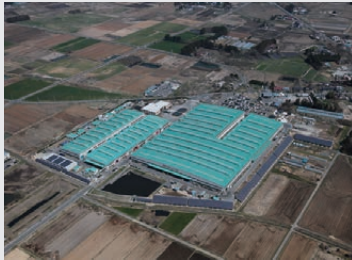
Tohoku Factory mega solar
