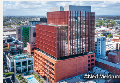
メルボルンの15階建て木造オフィス
