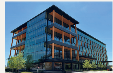
ダラスの7階建て木造オフィス
