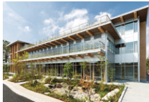
筑波研究所 新研究棟
