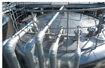
清浄レベルごとに回収した水を 200tのタンクに貯蔵し再利用
