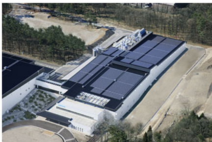
サントリー天然水 南アルプス白州工場
