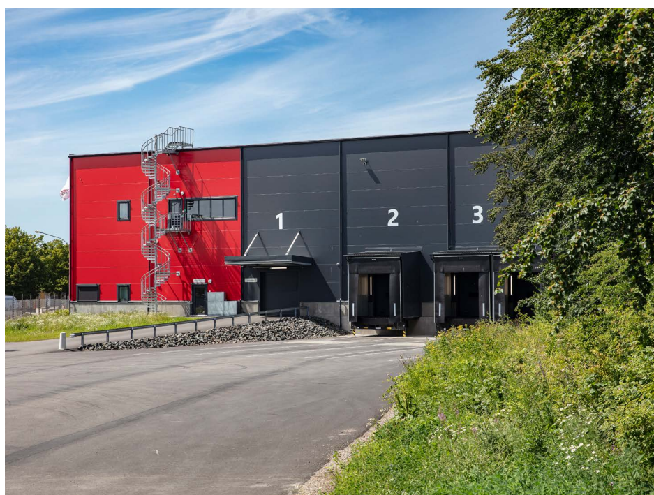
The property Ättehögen Östra 6 in Helsingborg.
