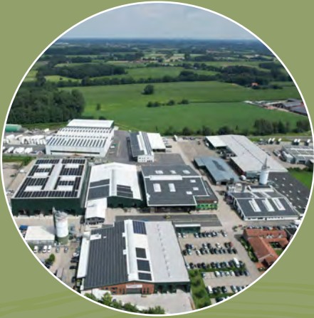
Terhalle Hauptstandort Ahaus-Ottenstein
