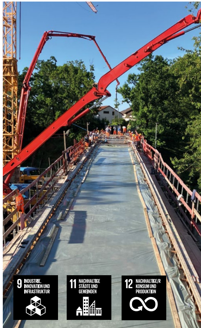
Effizient und ressourcenschonend: die Kombination von Holz und Carbonbeton im Brückenbau
