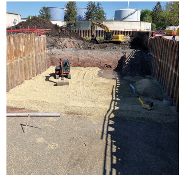
Kläranlage Böblingen-Sindelfingen: Baugrube Maschinengebäude und Belebungsbecken. Fertigstellung: 2025.
