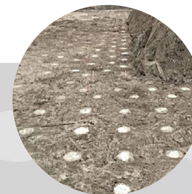
Eindrücke vom Bauvorhaben in Konstanz
