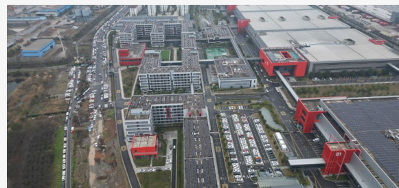
楼顶光伏项目
